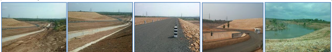
ดำเนินการก่อสร้างแล้วเสร็จ
