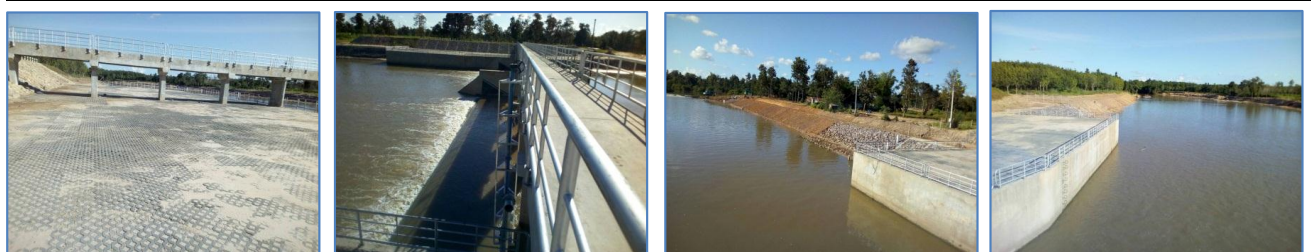
ดำเนินการแล้วเสร็จ
