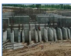
ขณะดำเนินการก่อสร้าง
