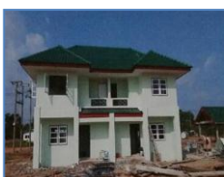
ก่อสร้างบ้านพัก
