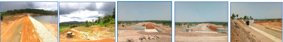
ขณะดำเนินการก่อสร้าง
